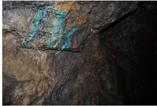
Oxido de cobre y hierro en las paredes de la galería
